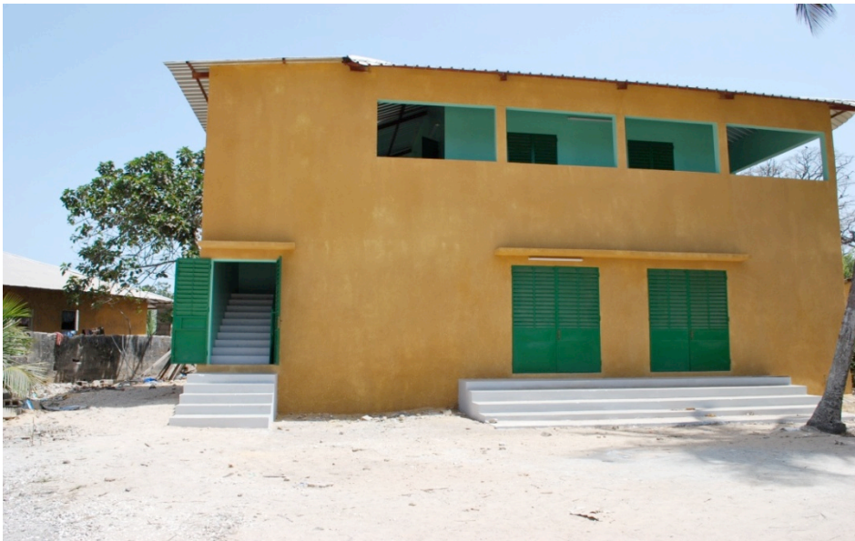
Nouveau bâtiment dédié à l'informatique
